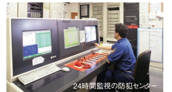
24時間監視の防犯センター
