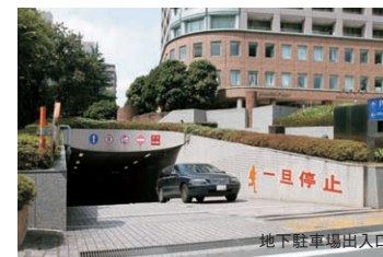
地下駐車場出入口
